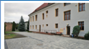
6. MOK – wykonanie parkingu, placu zabaw wraz z ogrodzeniem
