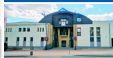
3. Termomodernizacja budynku Urzędu Miasta
