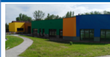
4. Budowa przedszkola nr 3 przy ul. Paderewskiego
