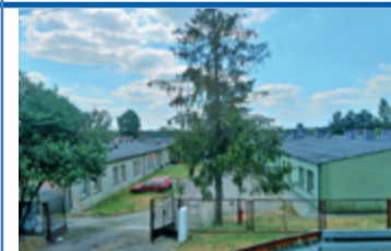
8. Termomodernizacja budynku komunalnego przy ul. Pokoju 37
