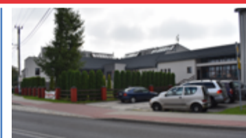
2. Termomodernizacja budynku Szkoły Podstawowej nr 4
