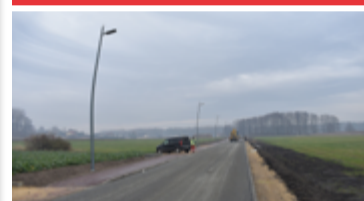
1. Budowa drogi gminnej Blych
