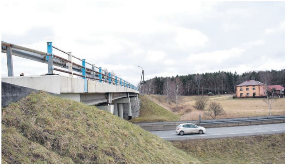
Węzeł – przy tym wiadukcie wiosną ruszy budowa węzła drogowego „Olszyce”
