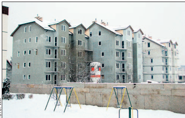
Stan budowy niektórych domów jest już bardzo zaawansowany.
