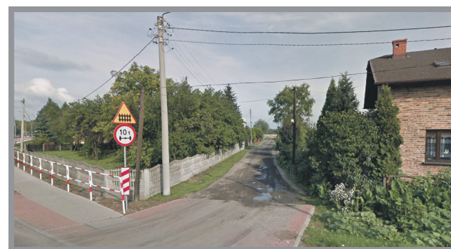
24. BUDOWA DROGI UL. HOŁDUNOWSKA „BOCZNA” Z WŁĄCZENIEM DO UL. GWARKÓW - 78 068,00 ZŁ
