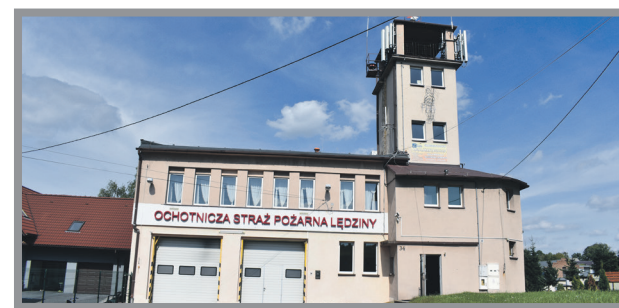
9. MODERNIZACJA DACHU BUDYNKU PRZY UL. KONTNEGO OSP - 79 059,27 Zł
