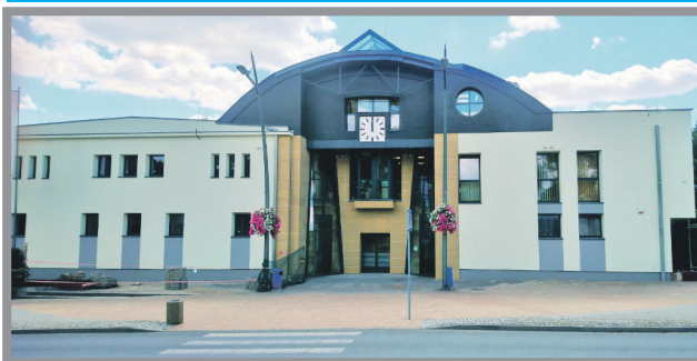
1. TERMOMODERNIZACJA BUDYNKU URZĘDU MIASTA W ŁĘDZINACH - 6 155 052,73 ZŁ
