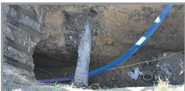
35. PROJEKT I BUDOWA SIECI KANALIZACJI UL. KRASZEWSKIEGO I MURCKOWSKIEJ - 30 995,39 Zł
