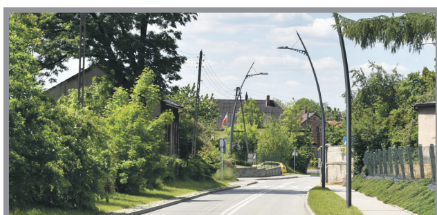
4. BUDOWA EFEKTYWNEGO ENERGETYCZNIE OŚWIETLENIA DROGOWEGO (UL. PADEREWSKIEGO) - 184 167,90 Zł
