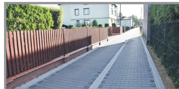
3. PRZEBUDOWA DROGI UL. PLEBISCYTOWEJ - 500 841,31 Zł
