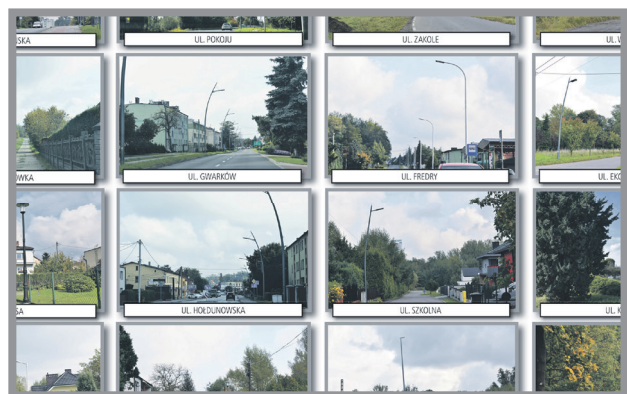
1. WYMIANA ŹRÓDEŁ ŚWIATŁA OŚWIETLENIA DROGOWEGO NA EFEKTYWNE ENERGETYCZNIE - 348 152,50 Zł
