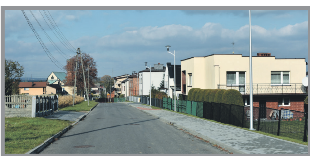
10. BUDOWA CHODNIKA I OŚWIETLENIA DROGOWEGO ULICY ZABYTKOWEJ W ŁĘDZINACH - 492 832,25 ZŁ
