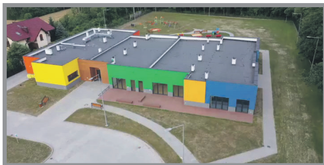
17. BUDOWA PRZEDSZKOLA NR 3 PRZY UL. PADEREWSKIEGO 17 - 5 263 594,50 ZŁ
