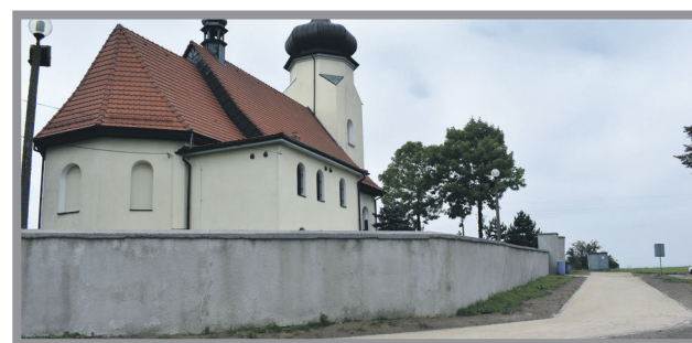
9. PRZEBUDOWA CHODNIKA WOKÓŁ KOŚCIOŁA ŚW. KLEMENSA - 102 901,41 ZŁ
