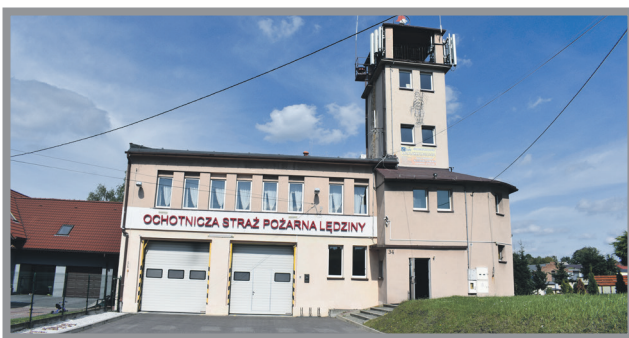
31. INFRASTRUKTURA SŁUŻĄCA DO ZAPEWNIENIA GOTOWOŚCI BOJOWEJ OSP ŁĘDZINY - 11 880,00 Zł
