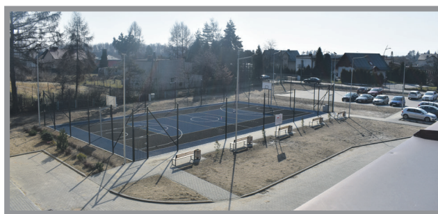
8. ROZBUDOWA I MODERNIZACJA SZKOŁY PODSTAWOWEJ NR 1 W ŁĘDZINACH, BUDOWA SALI GIMNASTYCZNEJ Z ŁĄCZNIKIEM DO BUDYNKU SZKOŁY PODSTAWOWEJ NR 1 W ŁĘDZINACH - PARKING I BOISKO - 206 756,37 Zł
