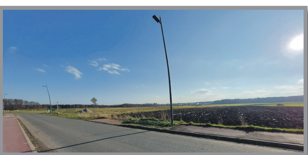
11. BUDOWA DROGI GMINNEJ UL. BLYCH - 3 720 790,93 ZŁ
