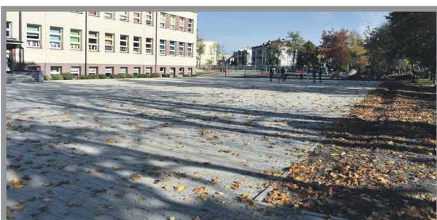
13. REMONT NAWIERZCHNI PLACU SZKOLNEGO SZKOŁY PODSTAWOWEJ NR 3 - 222 522,06 ZŁ
