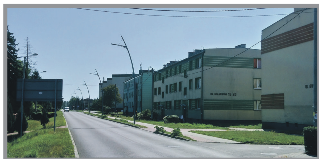
19. BUDOWA EFEKTYWNEGO ENERGETYCZNIE OŚWIETLENIA UL. GWARKÓW - 168 295,37 ZŁ
