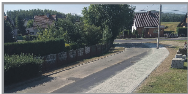
20. PRZEBUDOWA DROGI ORAZ BUDOWA CHODNIKA DO OŚRODKA ZDROWIA PRZY UL. FREDRY - 65 436,00 ZŁ
