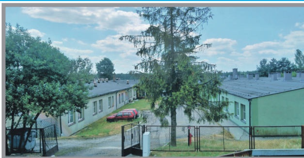
2. TERMOMODERNIZACJA BUDYNKU KOMUNALNEGO W ŁĘDZINACH PRZY UL. POKOJU 37 - 299 770,70 ZŁ
