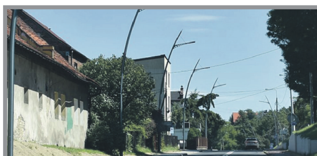
5. BUDOWA EFEKTYWNEGO ENERGETYCZNIE OŚWIETLENIA DROGOWEGO (UL. KONTNEGO) - 182 704,20 Zł
