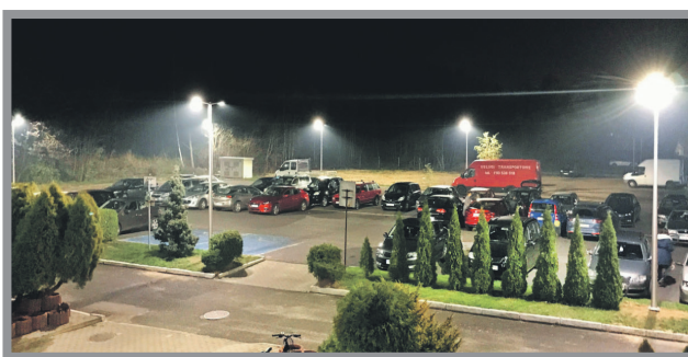
5. WYMIANA OŚWIETLENIA DROGOWEGO NA EFEKTYWNE ENERGETYCZNIE UL. GAŁCZYŃSKIEGO, ZABYTKOWA, WYSPIAŃSKIEGO, PARKING ORS „CENTRUM” - 159 039,00 ZŁ
