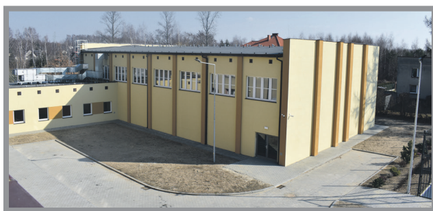
7. ROZBUDOWA I MODERNIZACJA SZKOŁY PODSTAWOWEJ NR 1 W ŁĘDZINACH, BUDOWA SALI GIMNASTYCZNEJ Z ŁĄCZNIKIEM DO BUDYNKU SZKOŁY PODSTAWOWEJ NR 1 W ŁĘDZINACH - SALA GIMNASTYCZNA Z ŁĄCZNIKIEM - 3 673 418,32 Zł
