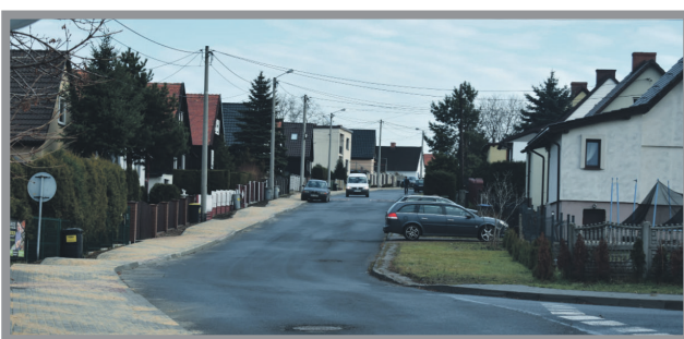
7. PRZEBUDOWA DROGI GMINNEJ UL. MICKIEWICZA W ZAKRESIE PRZEBUDOWY I BUDOWY CHODNIKA - 96 000,00 ZŁ
