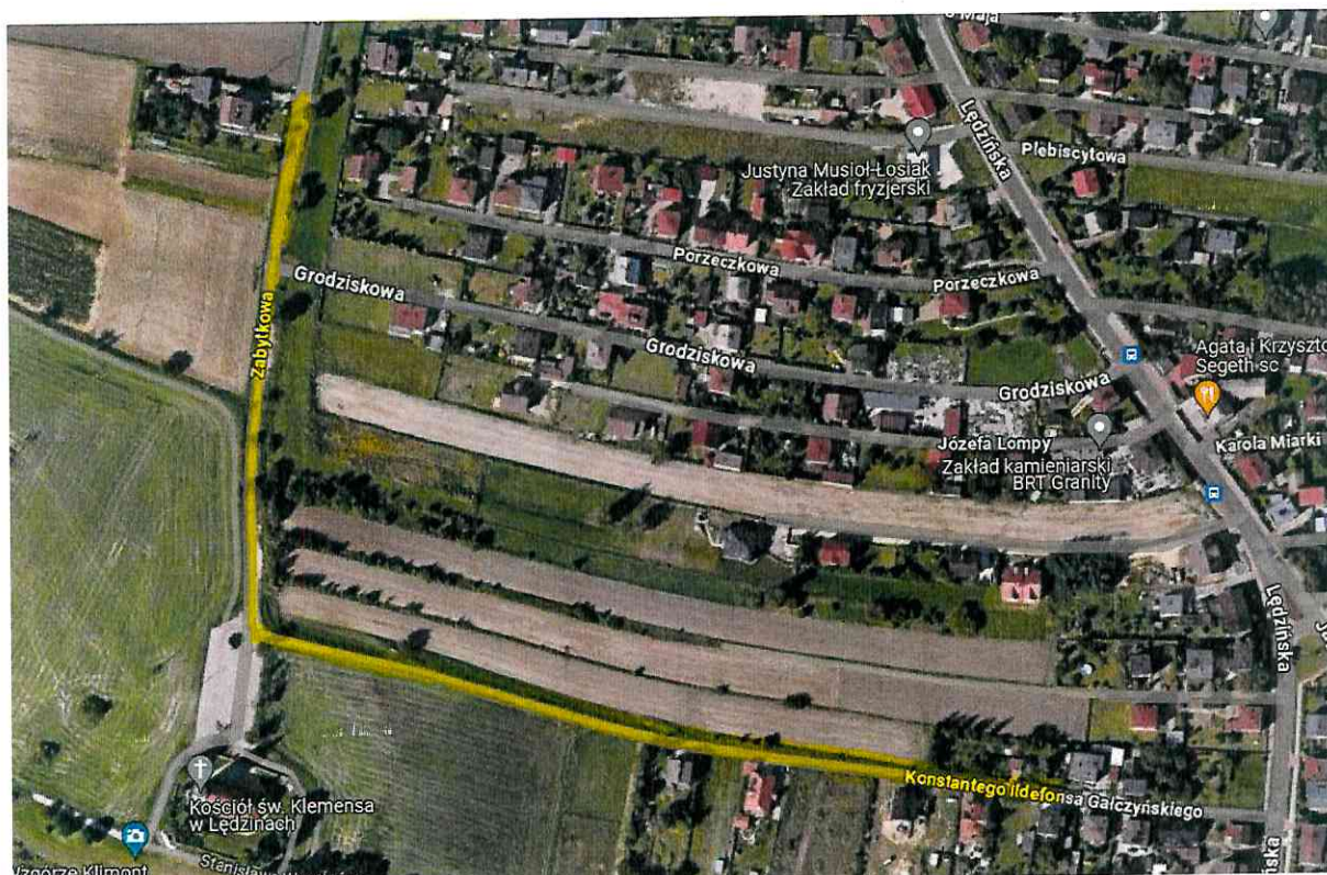
Rys. 1 Przebieg przebudowy drogi ul. Zabytkowej oraz Gałczyńskiego
