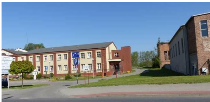
Zabudowania kopalni KWK Piast objęte strefą „B2” ochrony konserwatorskiej
