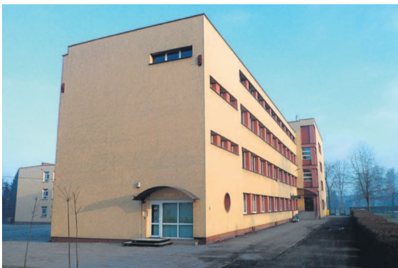
W budynku przy ul. Paderewskiego powstanie żłobek.
