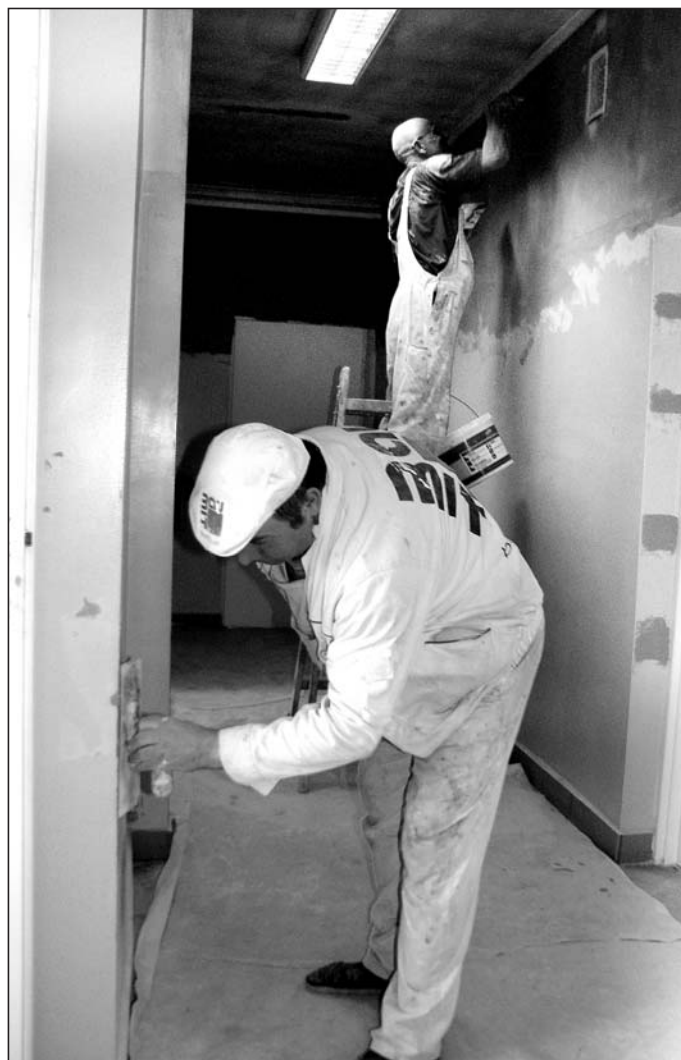
Andrzej Śliwiński (na pierwszym planie) i Adam Makuła kładą gładź gipsową w korytarzu przychodni.
