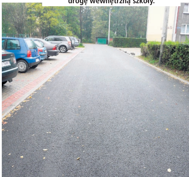
Trwają prace związane z modernizacją drogi dojazdowej do SP 3. W ubiegłym miesiącu wyremontowano tam też drogę wewnętrzną szkoły.
