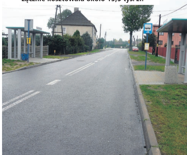
Na ulicy Zamkowej postawiono dwie nowoczesne wiaty przystankowe. Inwestycja objęła też wypuzłowanie peronów. Łącznie kosztowała około 15,5 tys. zł.
