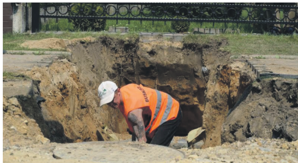
34. WYKONANIE PRZYŁĄCZY KANALIZACYJNYCH - DOMKI FIŃSKIE - 17 220,00 ZŁ
