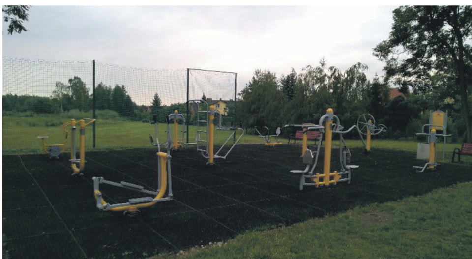
43. BUDOWA SIŁOWNI POD CHMURKĄ - UL. GRUNWALDZKA - BO – 89 163,82 ZŁ
