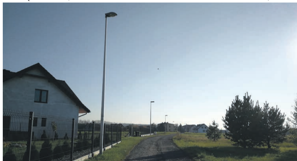
36. PRZEBUDOWA UL. SPACEROWEJ W LĘDZINACH W ZAKRESIE BUDOWY OŚWIETLENIA ZEWNĘTRZNEGO - 38 991,00 ZŁ
