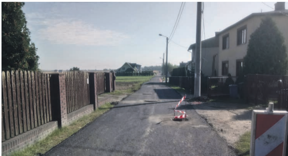
22. PRZEBUDOWA DROGI GMINNEJ UL. AZALIOWA - WYKONANIE NAWIERZCHNI ASFALTOBETONOWEJ - 182 204,82 ZŁ
