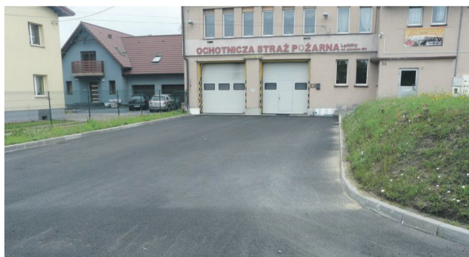
14. BUDOWA DROGI DOJAZDOWEJ DO BUDYNKU OSP ŁĘDZINY – 23 313,60 ZŁ
