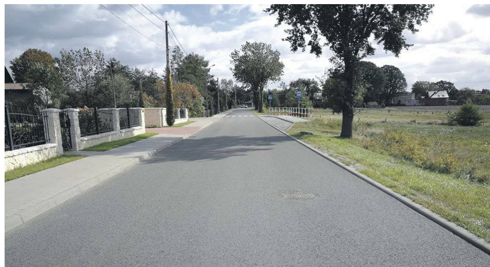
2. BUDOWA CHODNIKA - UL. UŁAŃSKA DOTACJA DLA POWIATU - 372 198,29 ZŁ
