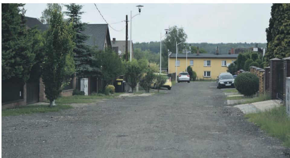
31. BUDOWA SIECI WODOCIĄGOWEJ UL. SOSNOWA I KWIATOWA - 219 509,96 ZŁ
