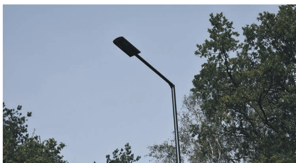
36. BUDOWA OŚWIETLENIA DROGOWEGO UL. LĘDZIŃSKA - 135 605,94 ZŁ
