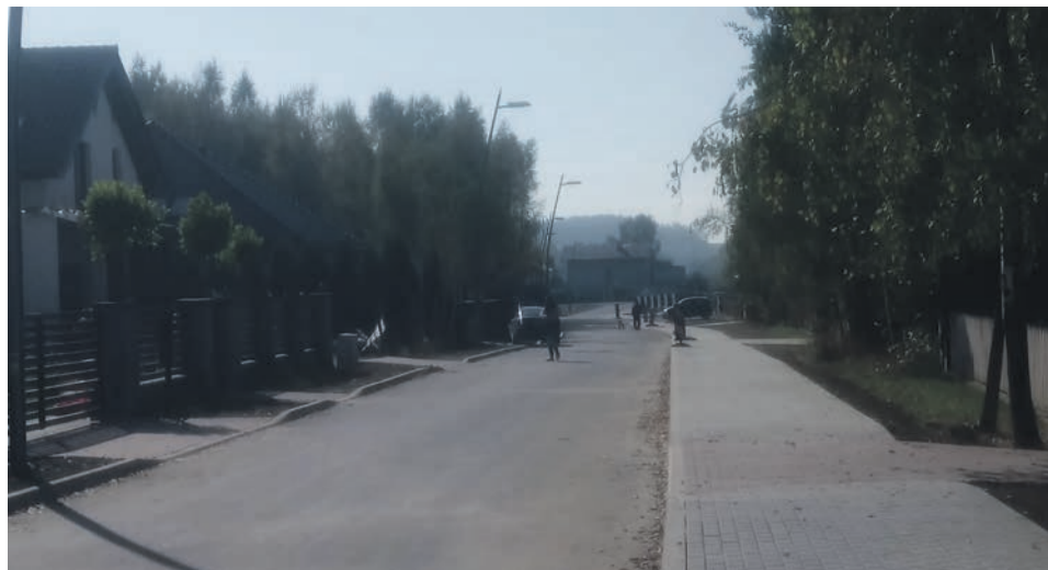
25. BUDOWA DROGI UL. ZACISZE 1 ETAP - 774 467,95 ZŁ
