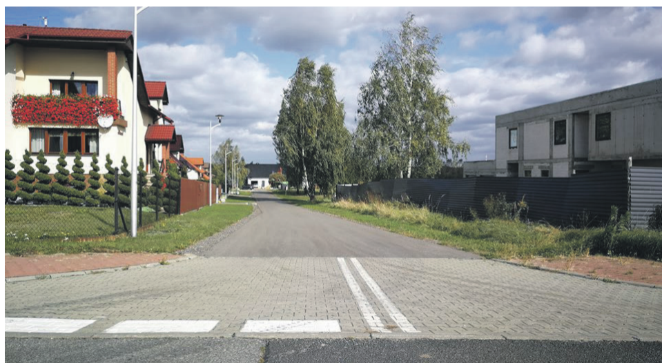
6. MODERNIZACJA UL. RÓŻANEJ - 87 155,13 ZŁ
