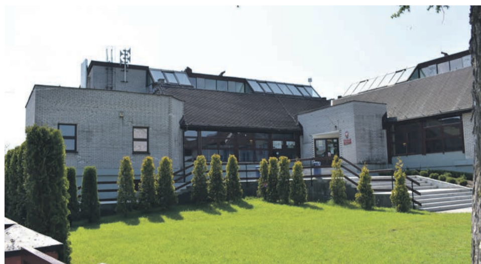
16. WYKONANIE PRZYŁĄCZA KANALIZACYJNEGO ZESPÓŁ SZKÓŁ - GOŁAWIEC - 23 240,10 zł
