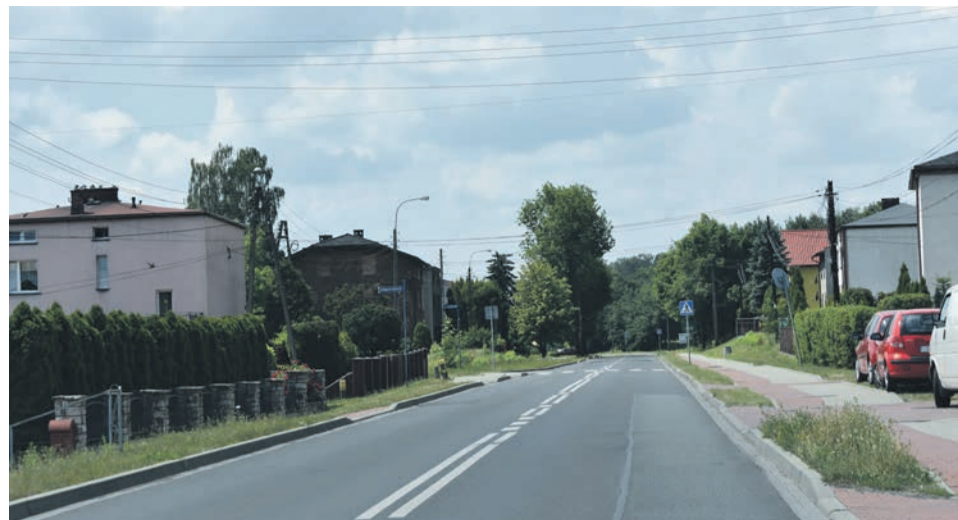
50. WYMIANA SŁUPÓW OŚWIETLENIA ULICZNEGO I OPRAW OŚWIETLENIOWYCH NA OŚWIETLENIE EFEKTYWNE UL. LĘDZIŃSKA, OFICERSKA I POKOJU - 299 549,58 ZŁ
