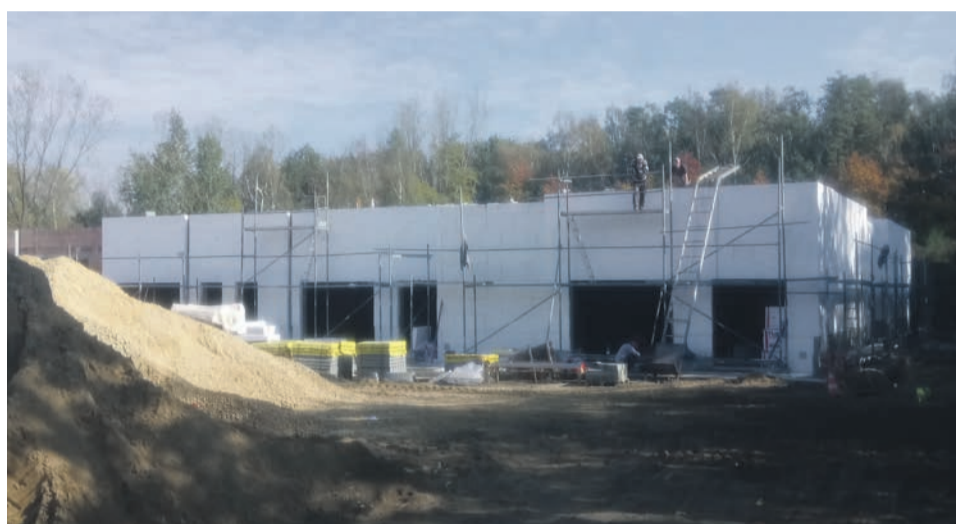
37. BUDOWA PRZEDSZKOLA - 4 989 829,45 ZŁ
