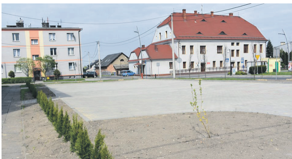
6. WYKONANIE MIEJSC PARKINGOWYCH PRZY UL. RUBERGA - XXV-LECIA - 106 433,36 ZŁ
