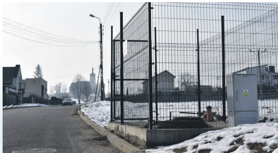
BUDOWA HYDROFOROWNI PRZEZ RPWiK W RAMACH PLANU MODERNIZACJI SIECI WODOCIĄGOWEJ - OK. 150 000 zł
