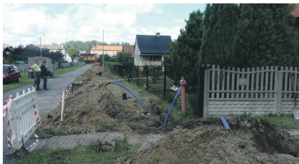
32. BUDOWA SIECI WODOCIĄGOWEJ W UL. LEWANDOWSKIEJ - 180 913,52 ZŁ
