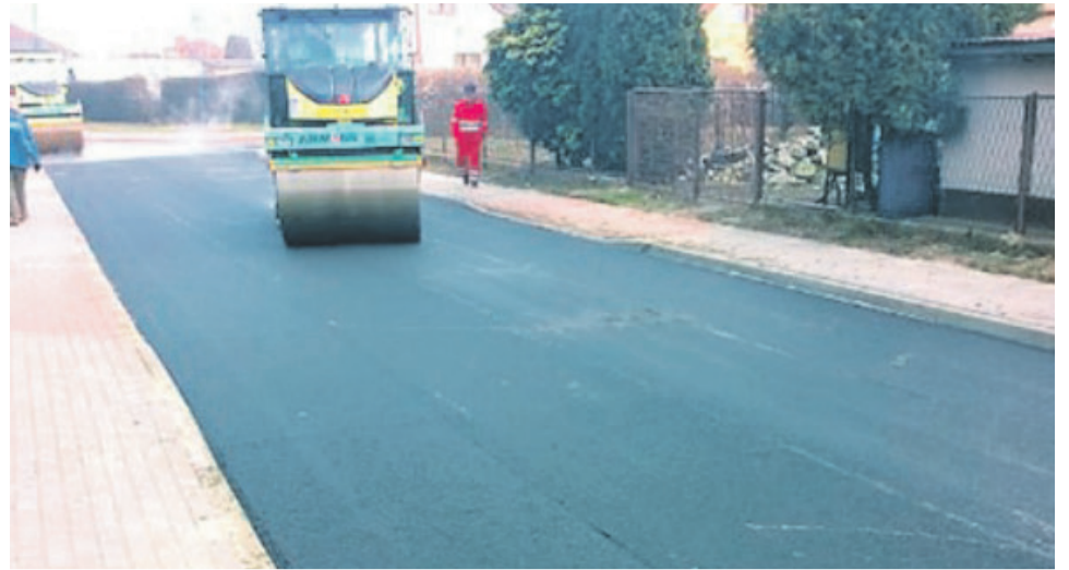
10. WYKONANIE NAWIERZCHNI DRÓG UL. WANDY I DĘBOWA, REMONT CHODNIKA UL. WANDY - 246 528,90 ZŁ
