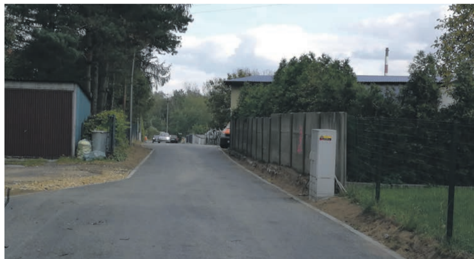
21. PRZEBUDOWA DROGI GMINNEJ UL. SZKOLNA - 629 093,59 ZŁ
