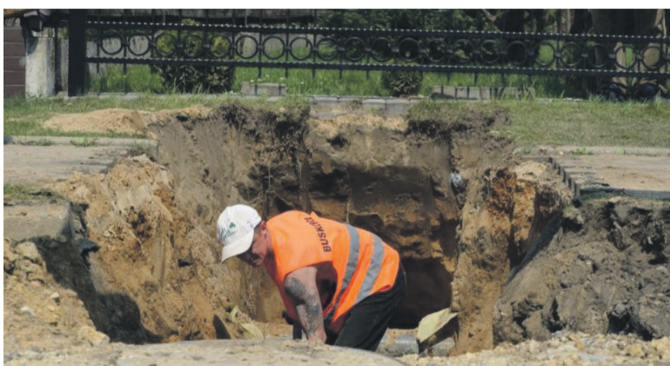
41. BUDOWA WODOCIĄGU UL. LEWANDOWSKA (OD RUBERGA DO PALMOWEJ) - 242 928,00 ZŁ
