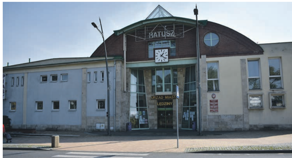
10. TERMOMODERNIZACJA BUDYNKU URZĘDU MIASTA - WYKONANIE DOKUMENTACJI - 58 917,00 zł
