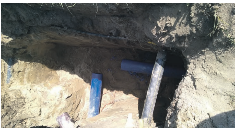
21. Budowa sieci wodociągowej ul. Ławecka - 91 942,50 zł
