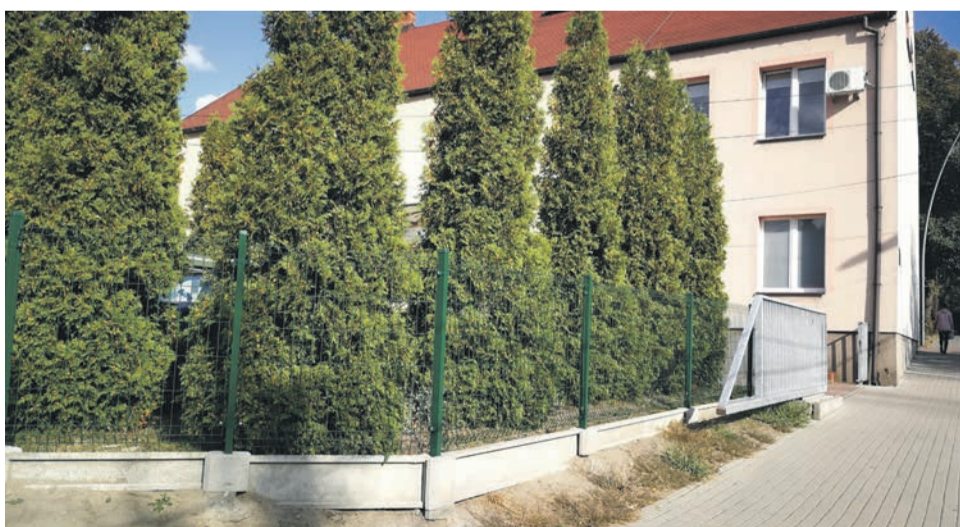
31. BUDOWA OGRODZENIA UL. ASNYKA 1 – 7 178,00 ZŁ
