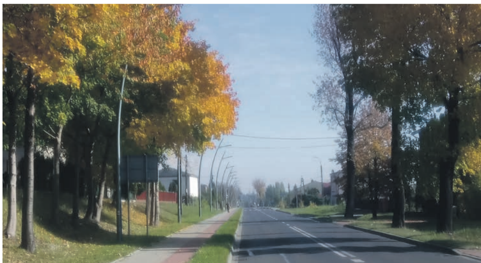
44. BUDOWA EFEKTYWNEGO ENERGETYCZNIE OŚWIETLENIA UL. POKOJU OD UL. JAGIELLOŃSKIEJ DO WIADUKTU - 214 020,34 ZŁ
