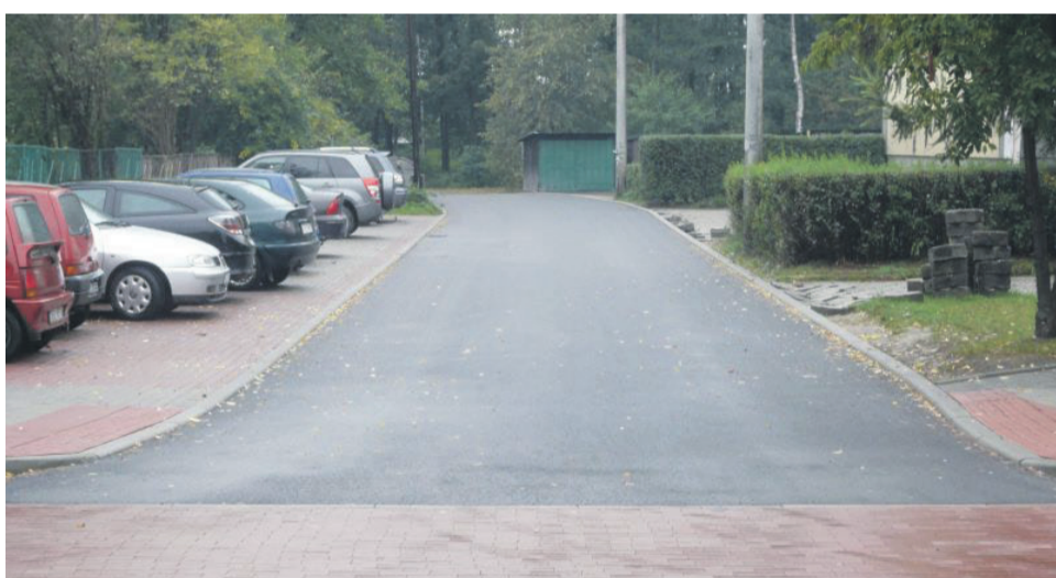
13. PRZEBUDOWA DROGI DOJAZDOWEJ DO SP3 – 115 568,29 ZŁ
