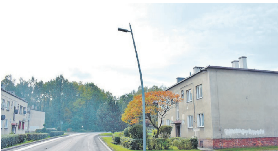
47. BUDOWA EFEKTYWNEGO ENERGETYCZNIE OŚWIETLENIA UL. OFICERSKA - 38 499,00 ZŁ
