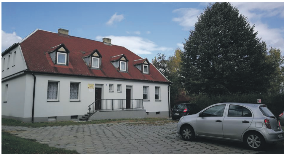
9. WYKONANIE PRAC BUDOWLANYCH - BUDYNEK PRZY KOLONII PIAST 5 - 5 500,00 zł
