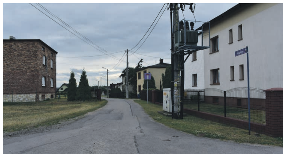
32. BUDOWA SIECI KANALIZACJI UL. AZALIOWA I CZAPLI - 464 085,90 ZŁ
