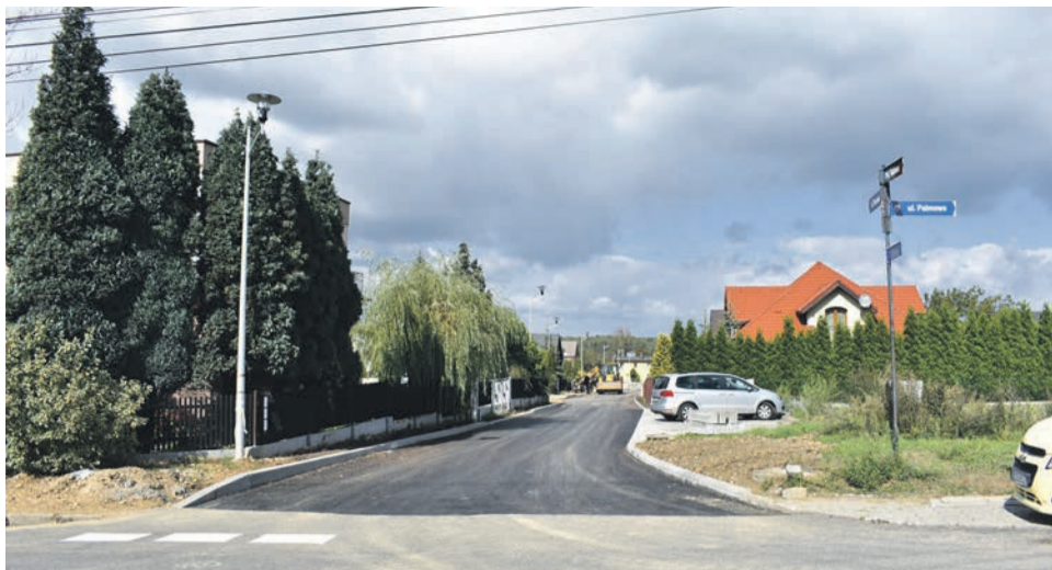
3. PRZEBUDOWA DRÓG GMINNYCH UL. SOSNOWA I UL. KWIATOWA - 759 792,37 ZŁ
