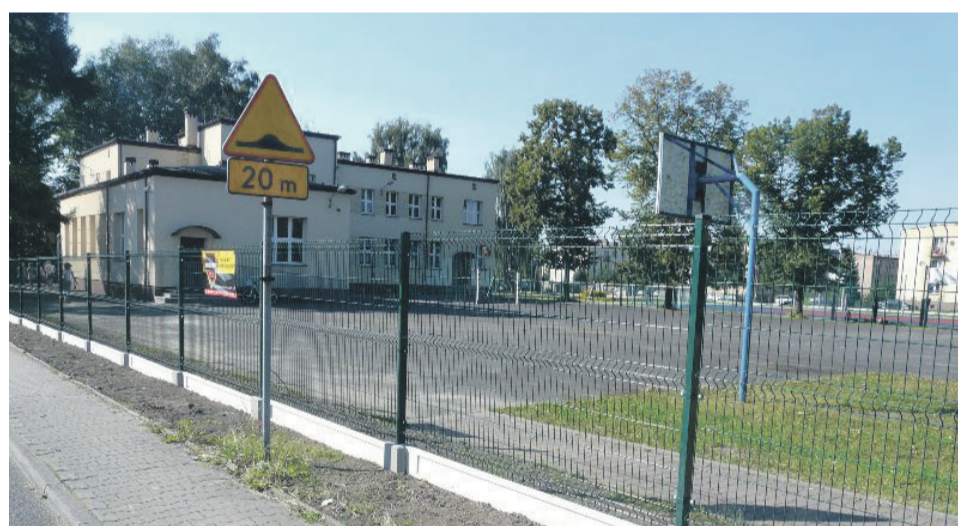
30. BUDOWA OGRODZENIA PRZY GIMNAZJUM NR 2 – 126 750,00 ZŁ
