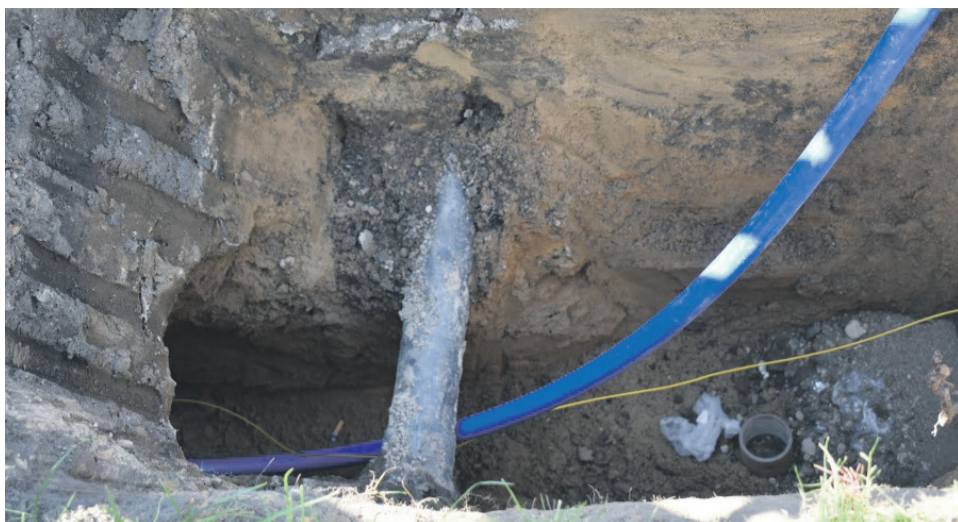
1. DOTACJA DLA MIESZKAŃCÓW - PODŁĄCZANIE NIERUCHOMOŚCI DO KANALIZACJI - 3 271 201,67 ZŁ
