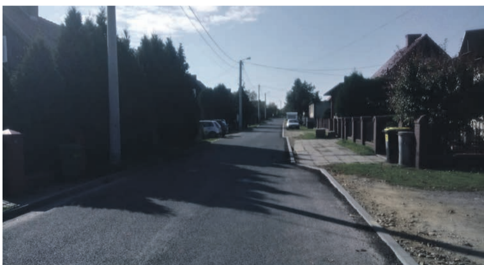
27. BUDOWA KRAWĘŻNIKÓW WRAZ Z STUDZIENKAMI TR AUGUTTA I UL. PRZODOWNIKÓW - 73 246,50 ZŁ
