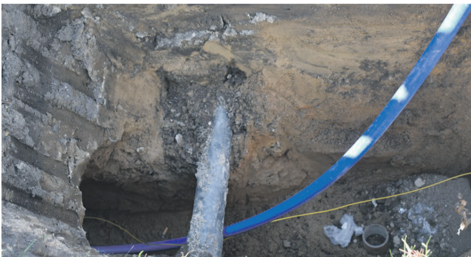
39. DOTACJA DLA MIESZKAŃCÓW - BUDOWA PRZYŁĄCZY KANALIZACYJNYCH - 307 380,13 ZŁ
