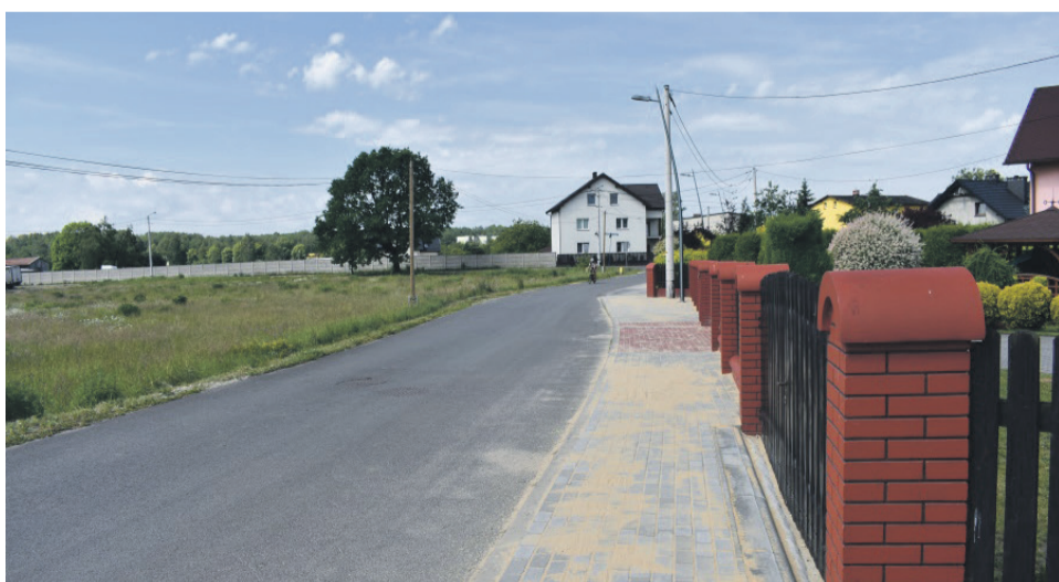
7. PRZEBUDOWA UL. MIŁEJ WRAZ Z BUDOWĄ OŚWIETLENIA DROGOWEGO - 254 118,00 ZŁ
