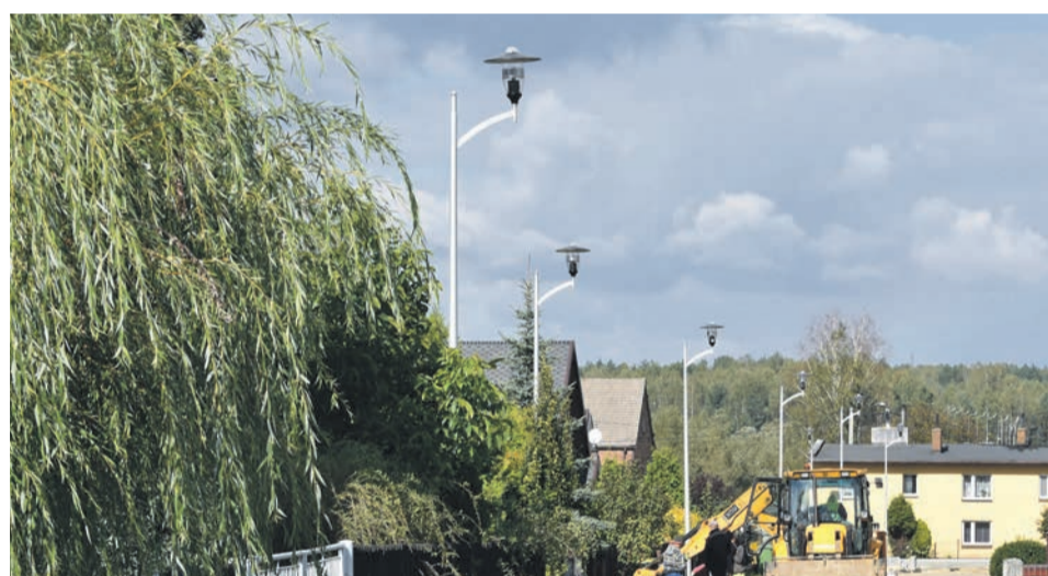
38. BUDOWA OŚWIETLENIA DROGOWEGO UL. SOSNOWA - 72 508,50 ZŁ
