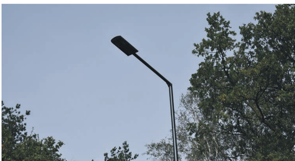
37. WYMIANA SŁUPÓW OŚWIETLENIA ULICZNEGO I OPRAW OŚWIETLENIOWYCH NA OŚWIETLENIE EFEKTYWNE UL. LĘDZIŃSKA, OFICERSKA I POKOJU - 69 485,06 ZŁ
