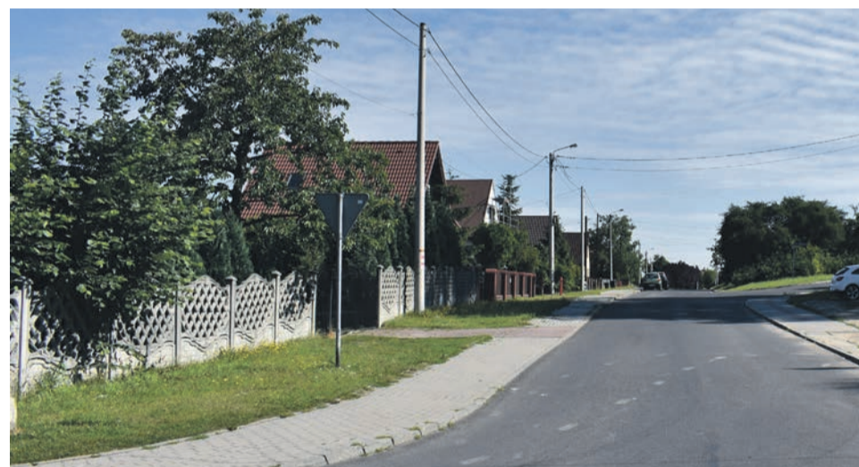
30. BUDOWA SIECI WODOCIĄGOWEJ UL. LEWANDOWSKIEJ - 148 591,47 ZŁ
