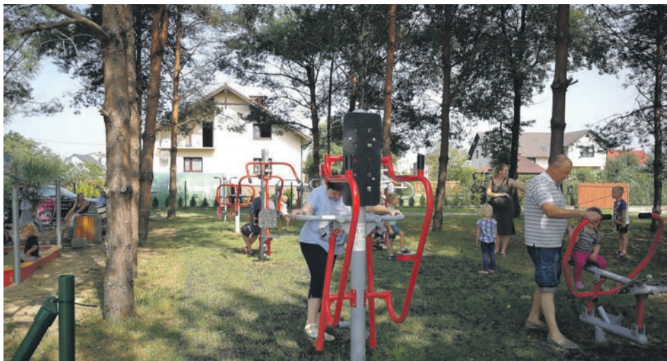
57. BUDOWA SIŁOWNI ZEWNĘTRZNEJ UL. JAGIEŁOŃSKA - 54 888,59 zł
