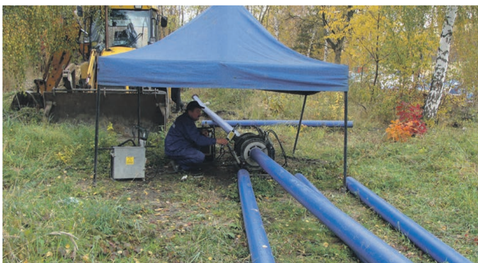
15. PRACE PRZY INSTALACJI KANALIZACYJNEJ - SP 1 - 34 612,02 zł
