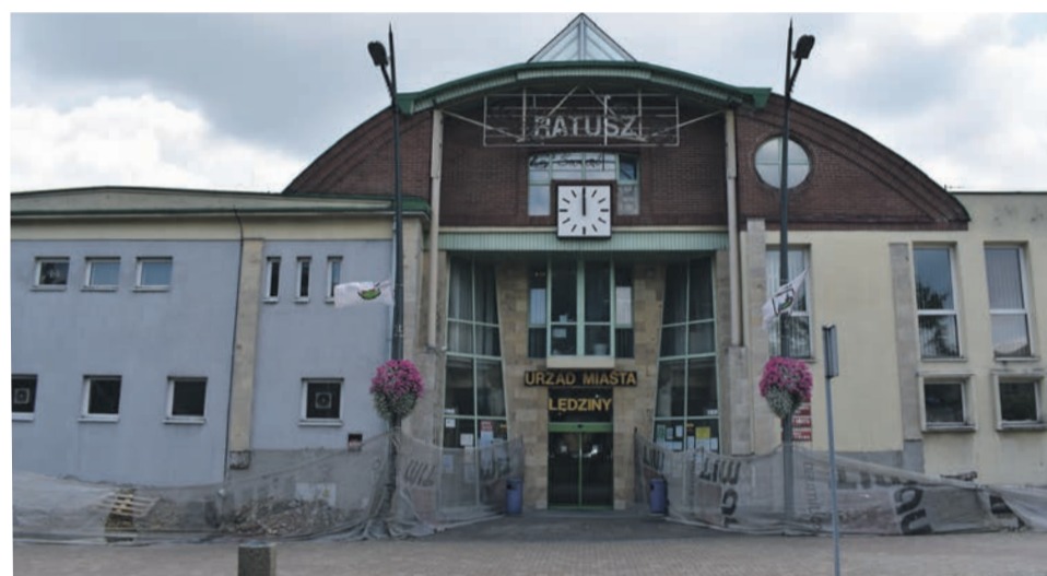
20. BUDOWA SIECI STRUKTURALNEJ BUDYNKU UM ŁĘDZINY - 99 990,45 ZŁ
