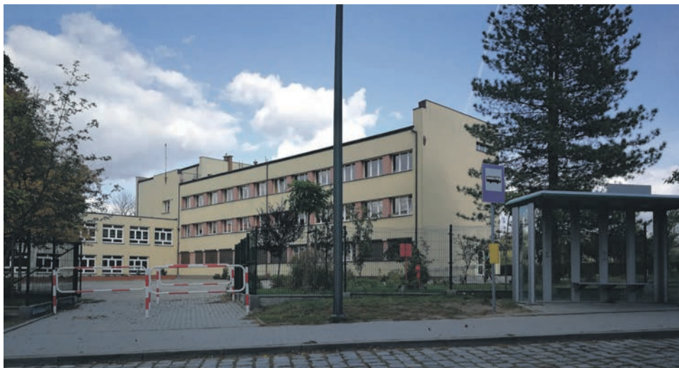
25. BUDOWA OGRODZENIA SP 1 – 36 896,06 ZŁ
