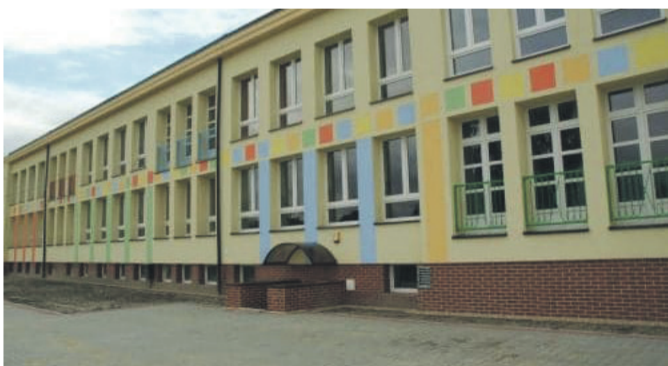
29. WYKONANIE KLIMATYZACJI W STREFIE ADMINISTRACYJNEJ (KUCHNIA) W PRZEDSZKOLU NR 2 – 58 572,60 ZŁ
