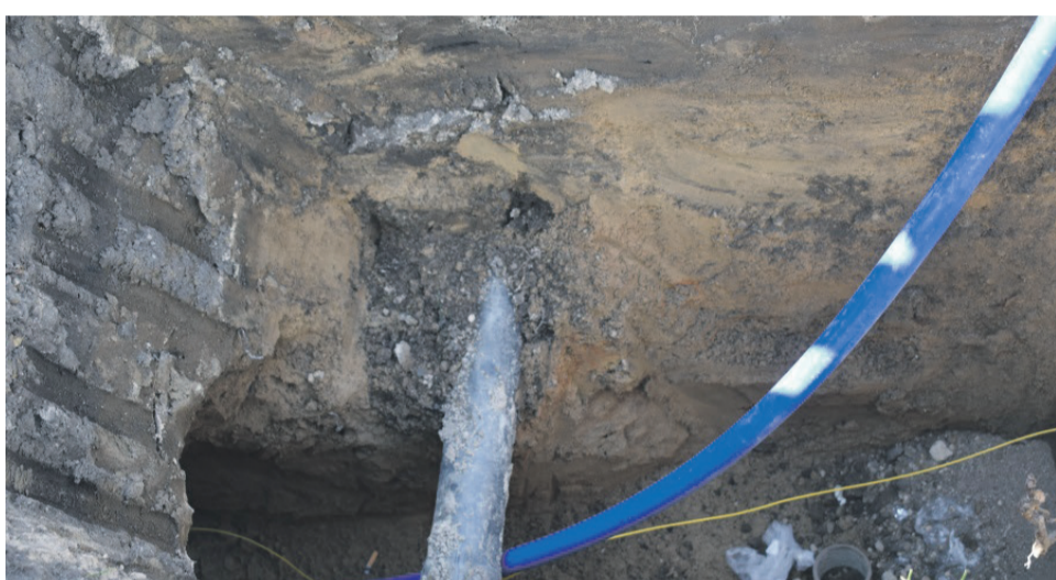
35. WYKONANIE PRZYŁĄCZY KANALIZACYJNYCH OBIEKTÓW TARGOWISKA MIEJSKIEGO - 35 670,00 ZŁ
