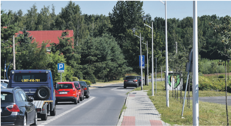
9. PRZEBUDOWA UL. DŁUGOSZA - BUDOWA CHODNIKA I OŚWIETLENIA DROGOWEGO - 50 048,70 ZŁ
