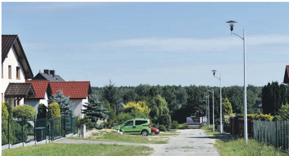
49. BUDOWA OŚWIETLENIA DROGOWEGO UL. POGODNA - 28 291,58 ZŁ
